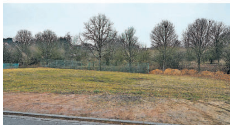
Diese Fläche neben dem Parkplatz wurde aufgeschüttet.
