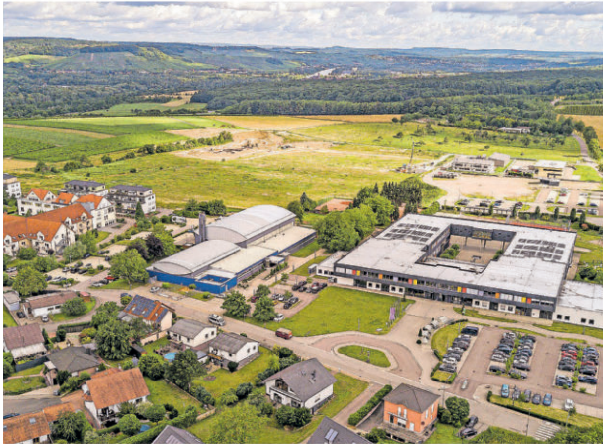
Perl aus der Vogelperspektive: Der neue Sportplatz entsteht in der Nähe des Schengen-Lyzeums.
