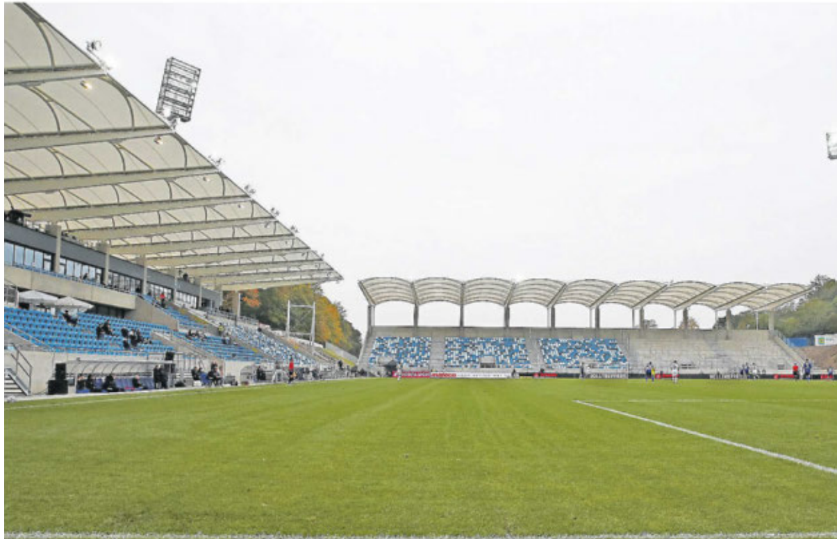
Der Rasen im Ludwigsstadion ist knapp drei Monate alt – aber schon in einem desaströsen Zustand. Daran wird sich so schnell auch nichts ändern, teilte die Stadt Saarbrücken auf Anfrage mit. FOTO: SCHLICHTER
