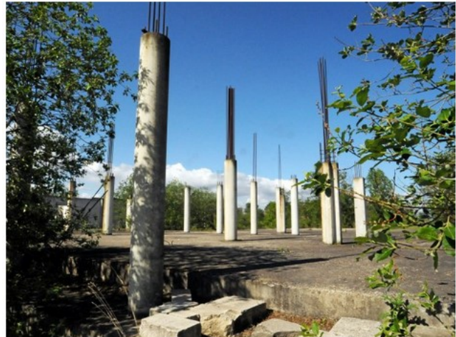
Für das Hotel wurden bereits große Mengen Beton verarbeitet – und die Arbeiten dann von Heute auf Morgen eingestellt. Foto: Hartmut Schwarz
