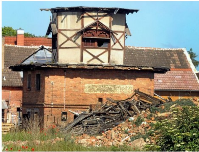
Einige der alten Gebäude des ehemaligen Gutshofes mussten aus Sicherheitsgründen bereits abgerissen werden. Foto: Hartmut Schwarz
