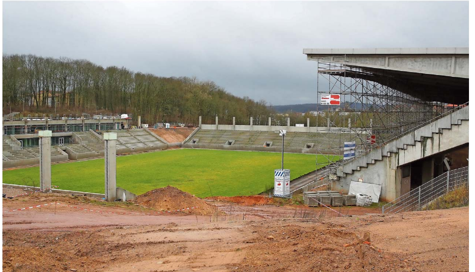
So sah sie am Samstag aus: die Baustelle im Ludwigspark.
