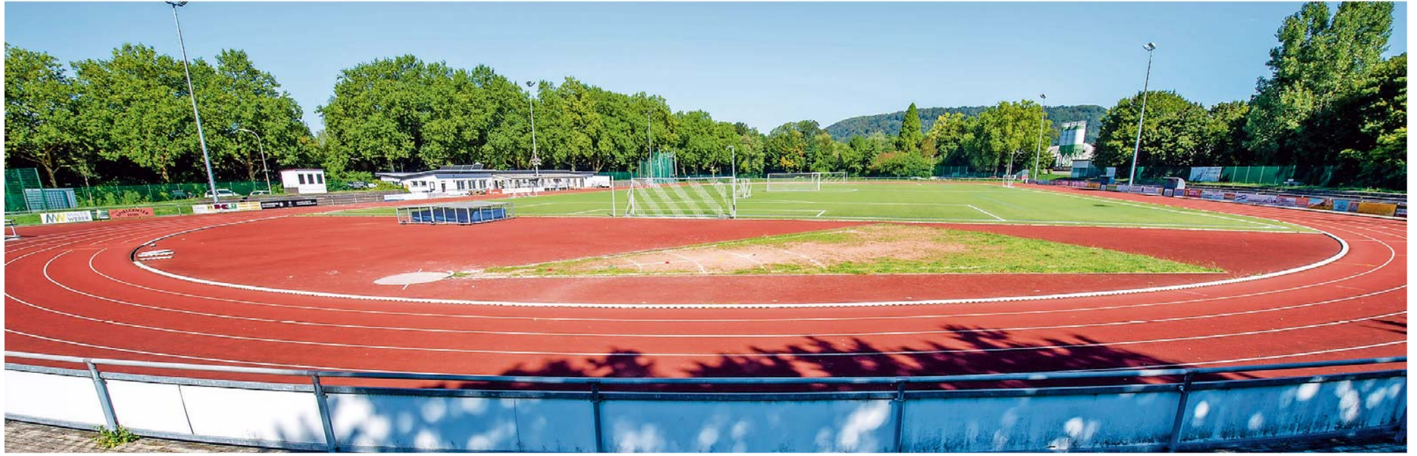
Das Merziger Blättelborn-Stadion wird von Schulen und Vereinen intensiv genutzt. Doch die Sportanlage ist zurzeit für den Wettkampfbetrieb gesperrt, eine Sanierung erforderlich.
