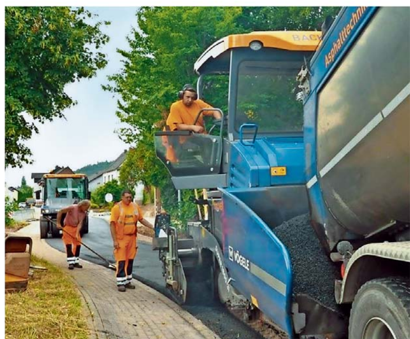
Da wurde noch am zweiten Bauabschnitt der Trassem Ortsdurchfahrt gearbeitet. Jetzt geht es an den nächsten Abschnitt. FOTO: MARION MAIER
