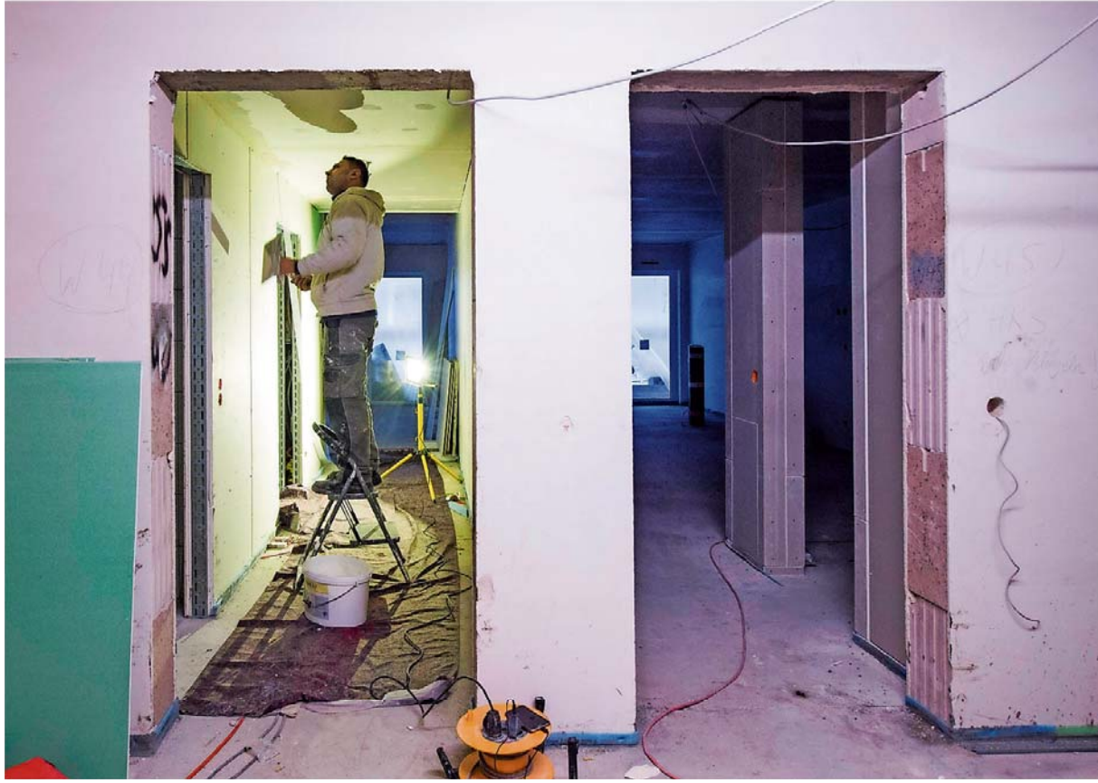
Zurzeit läuft der Innenausbau in den beiden Wohnblocks.
