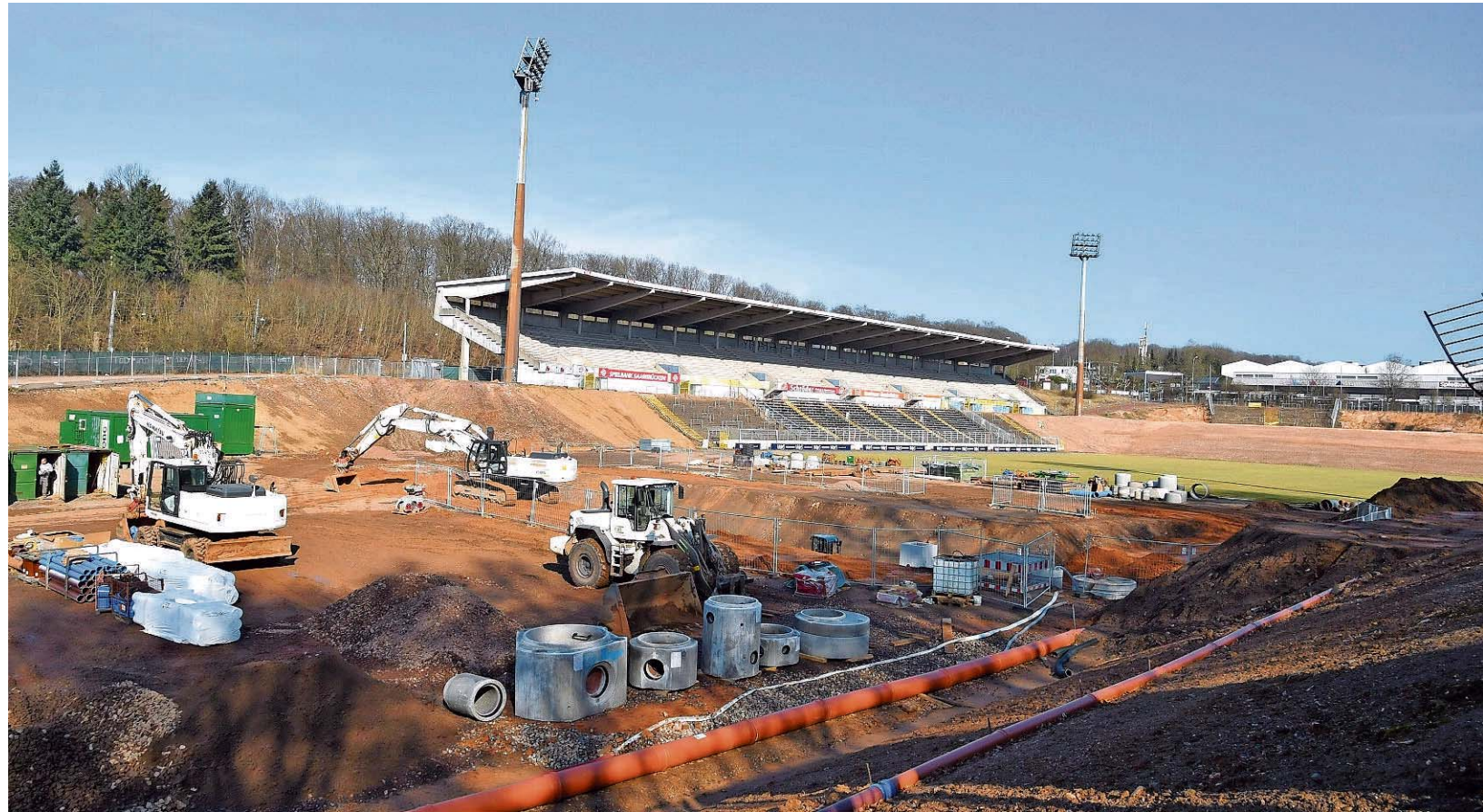
Der Abriss ist im Ludwigspark in vollem Gange – doch über die Pläne des Wiederaufbaus gibt es Streit.
