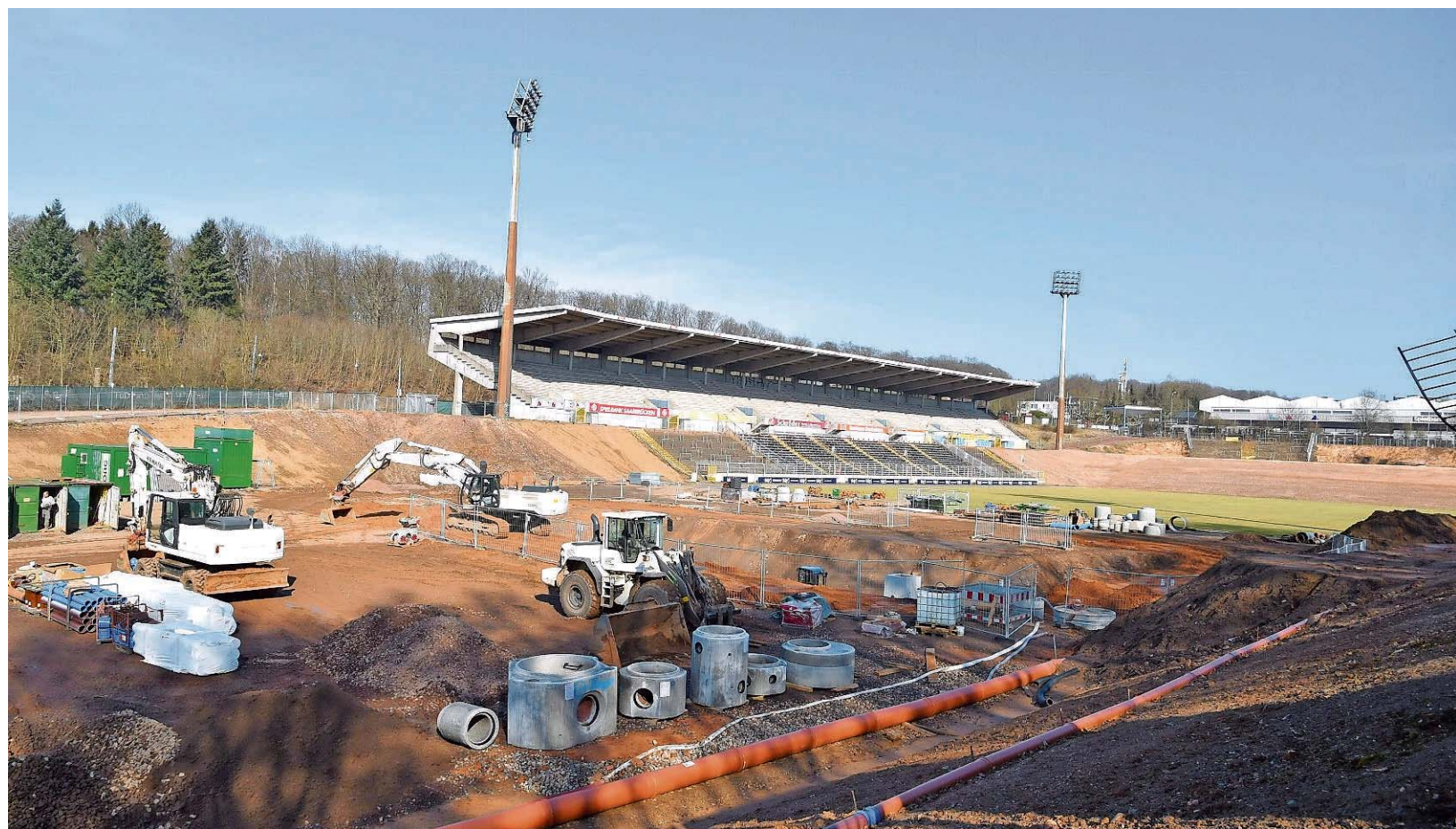
So sieht es derzeit auf der Baustelle des Saarbrücker Ludwigsparkstadions aus.
